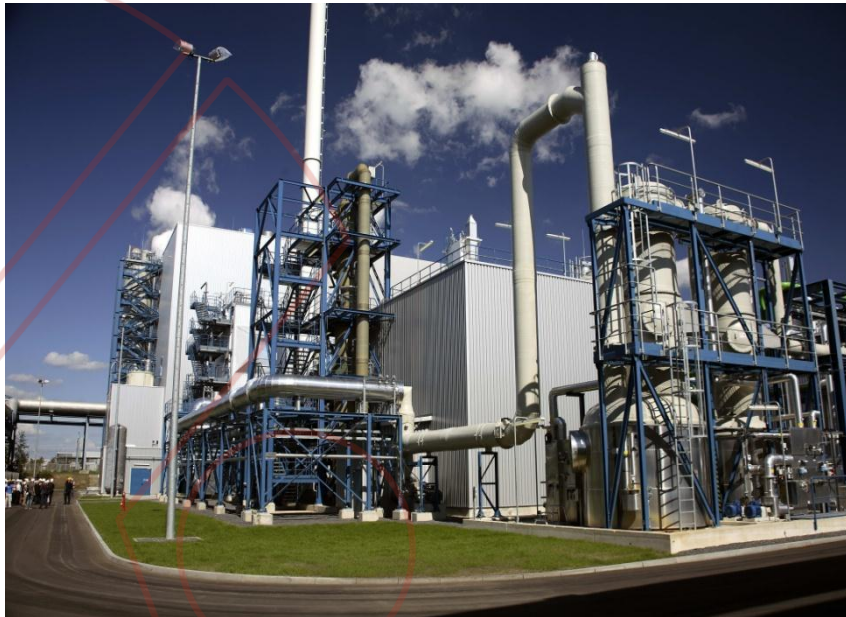
Foto: Schwarze Pumpe CCS-Pilotanlage Vattenfall Europe AG
